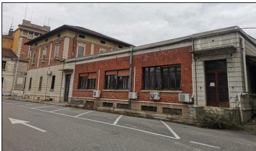
Figura 10 palazzina uffici e area posizionamento box di cantiere
