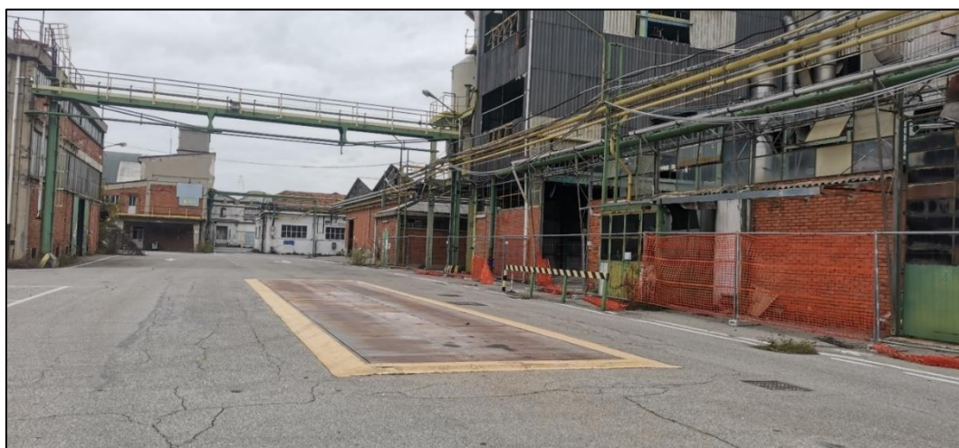
Figura 15: pesa presente in cantiere
