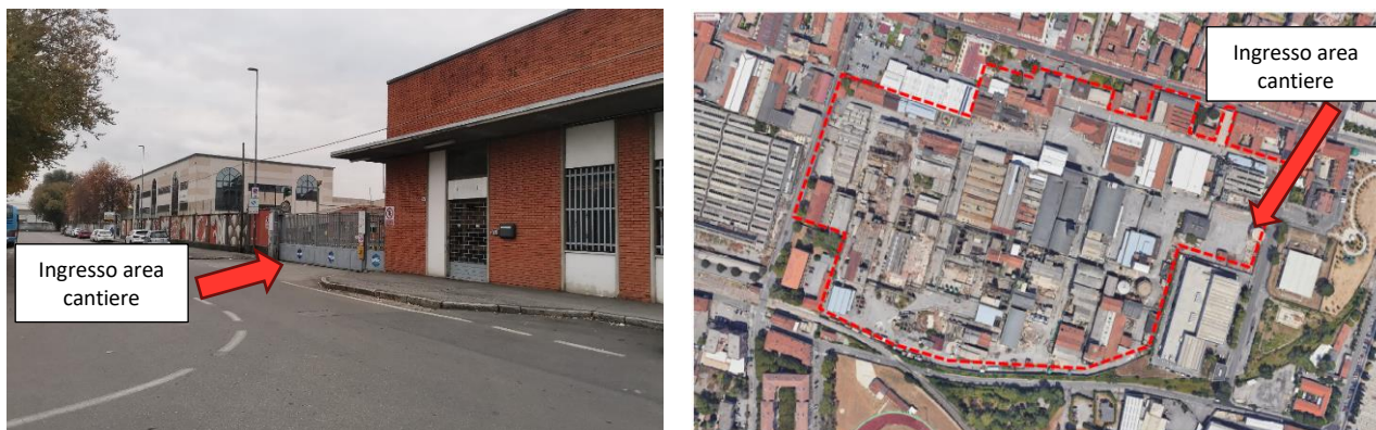
Figura 9: Ingresso al cantiere
